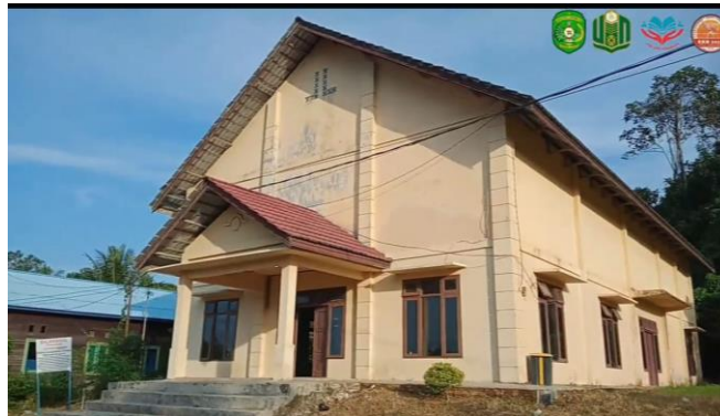
Gambar 6 Fasilitas Gedung Olahraga
